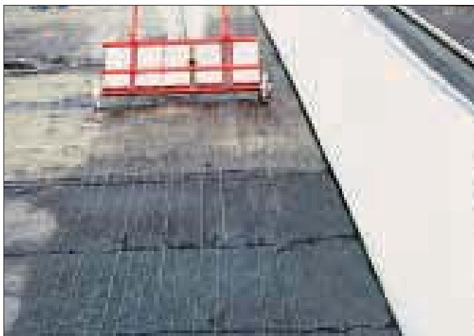
Fig. 1: Posa con carrello ALKORPLUS® 81069
