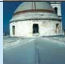
Létesítmény: Bari Cathedral (Bari, Italy, 1980) Termék: AlkorPlan® F (fogazott), 2000 m 2 Előző vízszigetelés: bitumen
