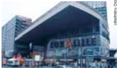
Létesítmény: Eurallie, Francia, 201002001 Termék: AlkorPlan® F mechanikai rögzítés, 35.000 m 2 Ezszigetelés bitumen
